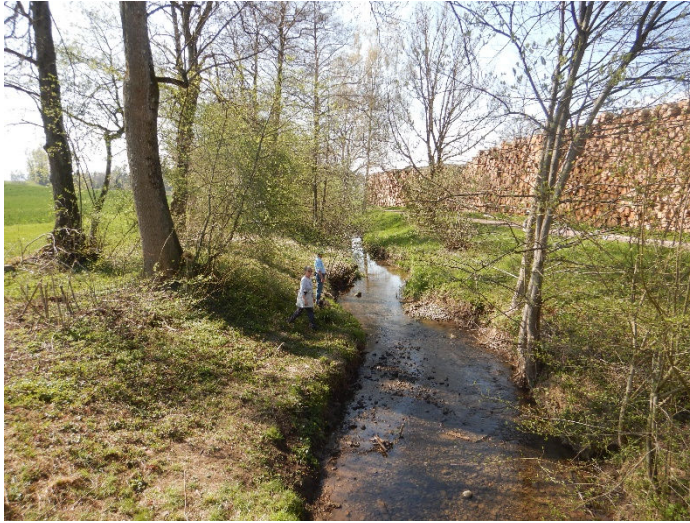
Abbildung 20: Teilabschnitt des Abschnitts Ha_Met mit einer Gerinnesohlenbreite zwischen 3.0 m und 3.5 m, Blick in Fliessrichtung
