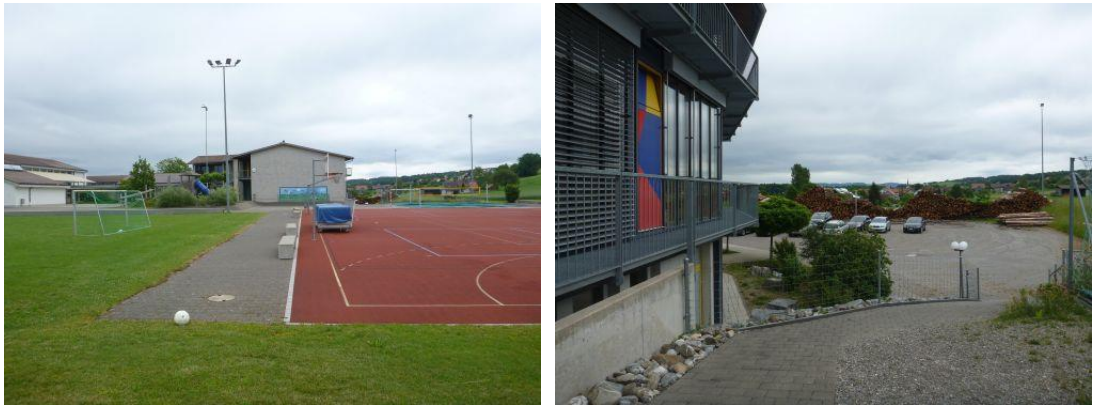
Abbildung 18: Mosbach, Eindolung beim Schulhaus, Blick in Fließrichtung
