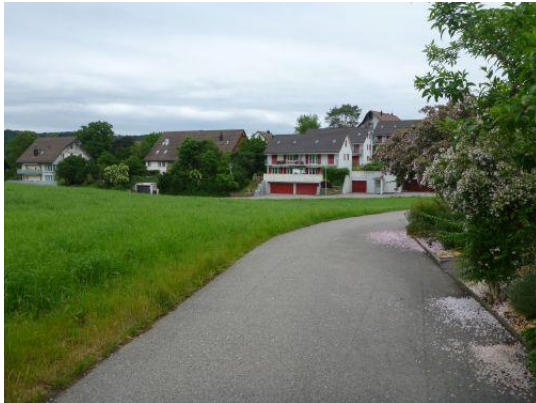
Abbildung 23: Weierbach, Eindolung Landwirtschaftszone Boll, Blick in Fließrichtung
