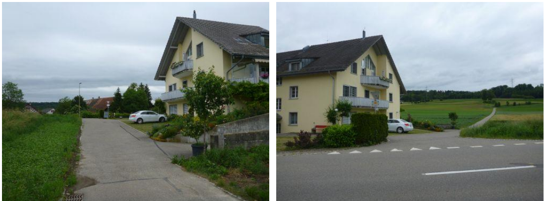
Abbildung 25: Schuepigraben, Eindolung Geerenstrasse, Blick in (links) und gegen Fließrichtung (rechts)
