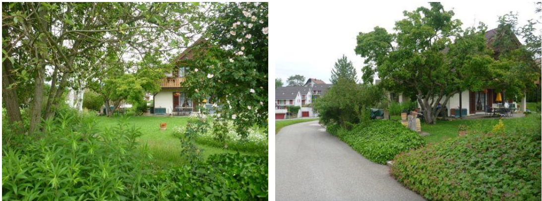
Abbildung 22: Weierbach, Eindolung Im Boll, Blick in Fließrichtung
