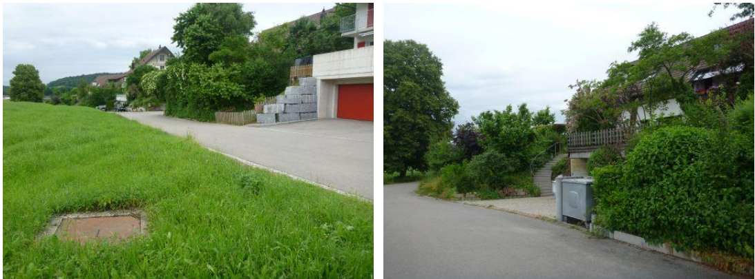
Abbildung 24: Weierbach, Eindolung Mühlestrasse, Blick in Fließrichtung
