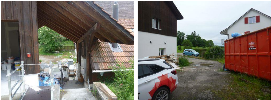
Abbildung 27: Schuepigraben, Eindolung unterhalb alter Mühle, Blick in Fließrichtung
