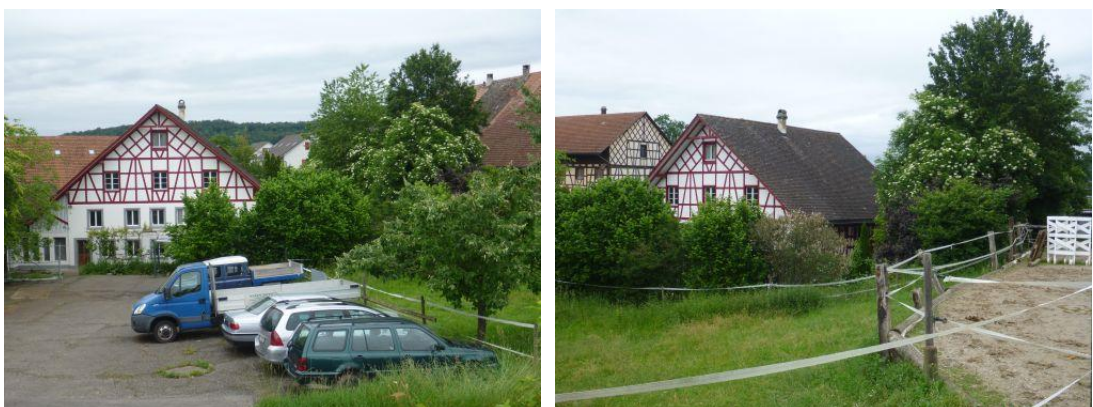
Abbildung 26: Schuepigraben, Eindolung alte Mühle, Blick in Fließrichtung
