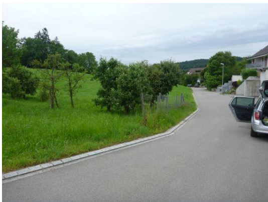
Abbildung 28: Schuepigraben, Eindolung parallel Mühlestrasse, Blick in Fließrichtung
