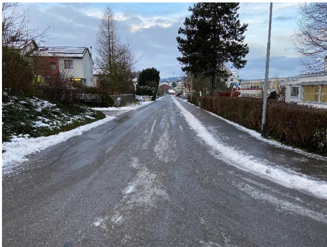
Abbildung 14: Abschnitt "Breitestrasse I" Sicht von Osten, 13.01.2021
