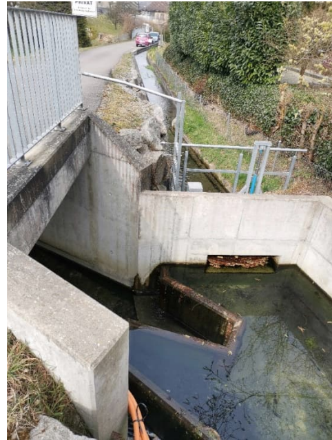
Abbildung 38: Abschnitt "WRK-1" Trennbauwerk, 18.03.2022
