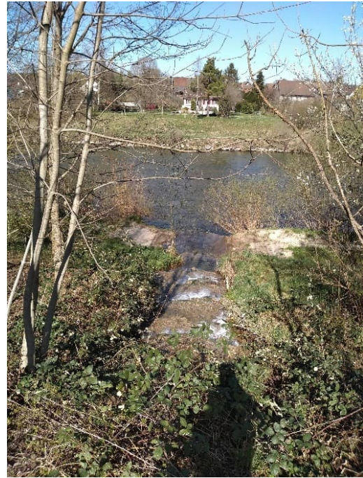
Abbildung 35: Abschnitt "Einmündung" Nord, 23.03.2020
