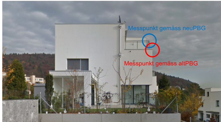
Abb. 23 Darstellung Messpunkte gemäss altPBG/neuPBG. Ohne die entsprechende Ergänzung müsste bei einem Neubau das Erdgeschoss rund 1 m tiefer angesetzt werden.
