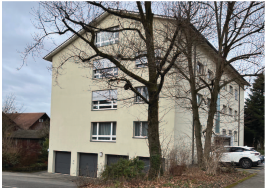
Abb. 27 - Ewiges Wegli 17 - Bestandesrechtliches Gebäude in der Bauzone WG2b
