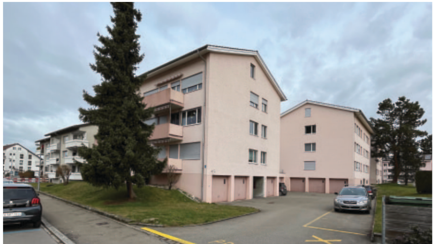
Abb. 28 - Ewiges Wegli 12 - Bestandesrechtliches Gebäude in der Bauzone W2a
