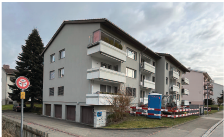
Abb. 29 - Ewiges Wegli 16/18 - Bestandesrechtliches Gebäude in der Bauzone W2a
