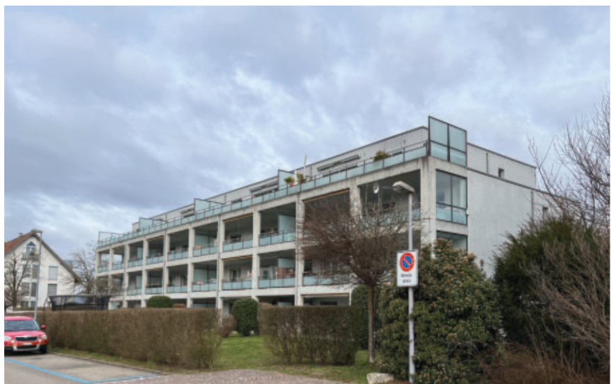
Abb. 32 - Rätchengässli 31/33 (links) - Gebäude in der Zone WG2b
