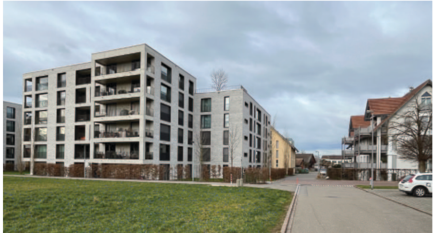
Abb. 33 - Rätchengässli 34/36 (links) - Gebäude in der Zone WG2b / Privater GP Im Gässli
