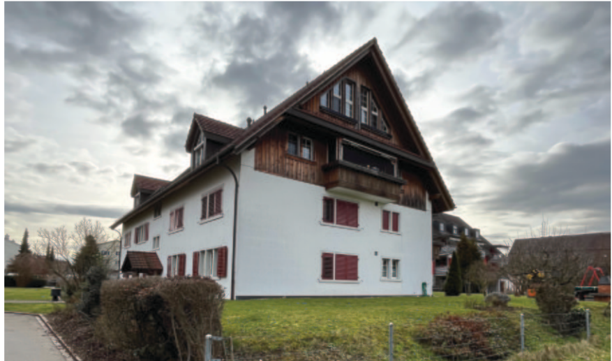
Abb. 30 - Ewiges Wegli 29 - Gebäude in der Bauzone WG2b / GP Rätchengässli Ost
