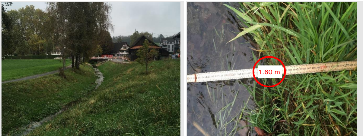
Abbildung 11: Abschnitt 2 zwischen Durchfluss Chamstrasse und Steg bei Kreuzung Herrenweg / Hagendornstrasse
