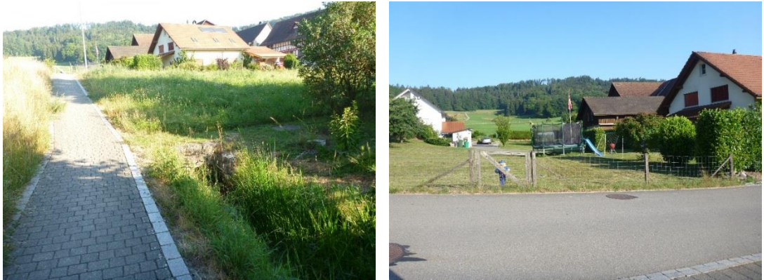
Abbildung 20: Auslauf des eingedolten Rorbachs (links) und Verlauf (gF).
