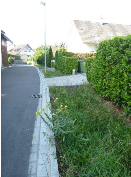
Abbildung 16: Abschnitt As_03 mit Blick auf den Zusammenfluss mit dem HWE (oben links), das Gerinne gF (oben rechts) und Sicht auf die Überfahrten (unten, iF).
