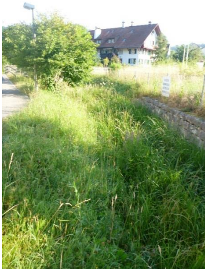
Abbildung 18: Offener Abschnitt des Dorfbachs innerhalb des Siedlungsgebiets (oben rechts, unten, gF). Einlauf der unterliegenden Dole (oben links).
