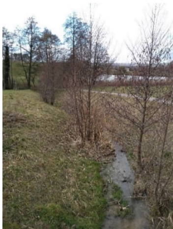
Abbildung 9: Abschnitt "Landstrasse", 18.02.2020 (Sicht in Richtung Südwesten)
