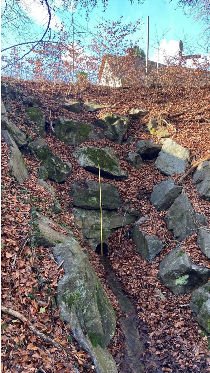
Abbildung 7: Übergang Dole zu offenem Gerinne mit Doppelmeter, Schalchenrietbach, östlich Marthalerstrasse, 28.01.2022
