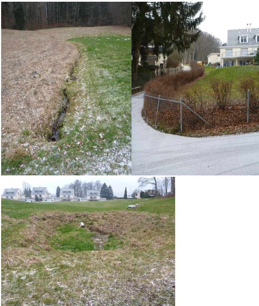
Abbildung 19: Offener Abschnitt ausserhalb des Siedlungsgebiets (oben links), Beginn der Eindolung (unten) und Verlauf der Dole durch privaten Garten (oben rechts).
