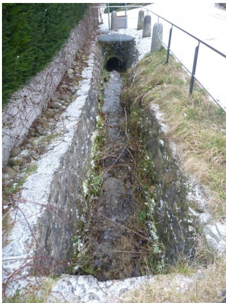
Abbildung 23: Blick in Fließrichtung auf den künstlichen Abschnitt innerhalb Mauern unterhalb der Überfahrt.
