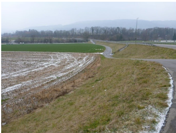
Abbildung 18: Eingedolter Abschnitt mit Blick in Fließrichtung
