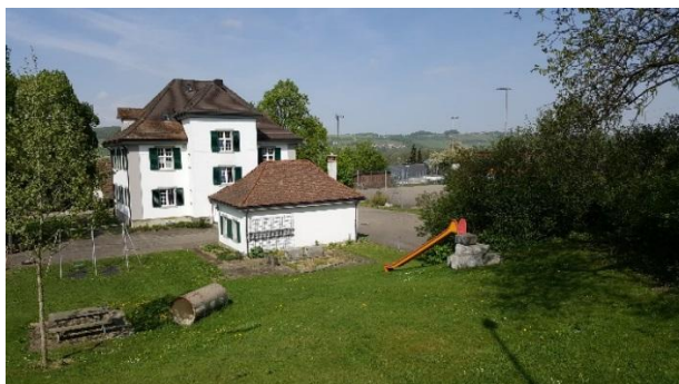
Abbildung 8: Abschnitt "Schuelgraben Süd", 25.04.2018
