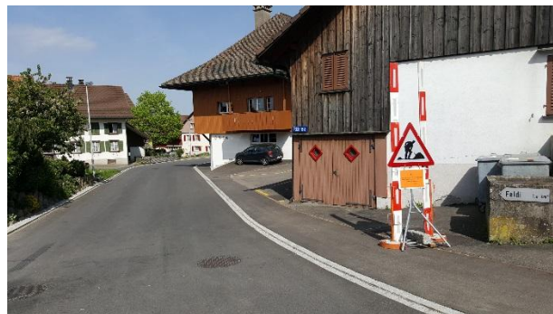
Abbildung 13: Abschnitt "Hardbach" West, 25.04.2018
