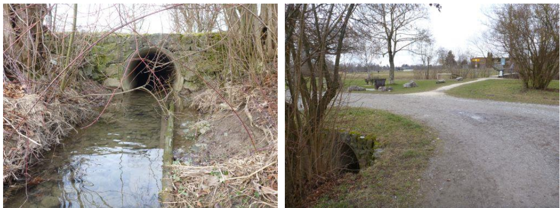
Abbildung 29: Eindolung vor Mündung – Einlauf (links), eingedolter Abschnitt (rechts), Blick in Fließrichtung
