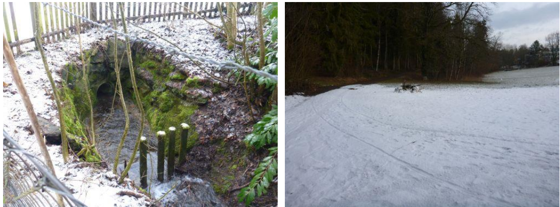
Abbildung 21: Eindolung Geerenstrasse – Einlauf (links) und eingedolter Bereich (rechts), Blick in Fliessrichtung
