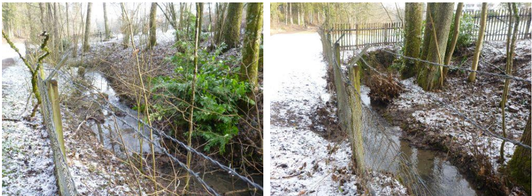
Abbildung 20: Offener Abschnitt entlang Rütiweg, Blick in Fließrichtung
