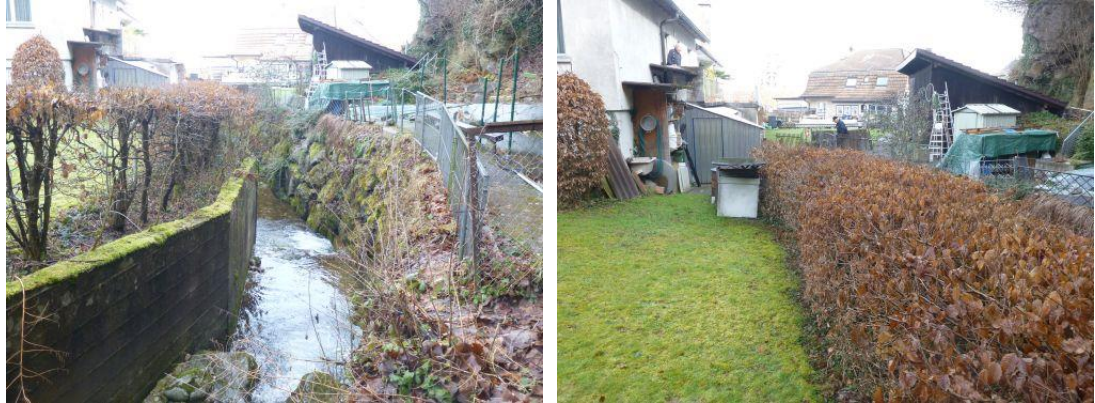
Abbildung 31: Dorfbach vor Eindolung, Blick in Fließrichtung
