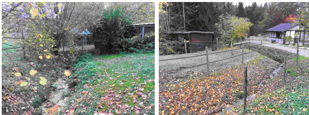
Abbildung 23: Rütibach, Blick in Fließrichtung
