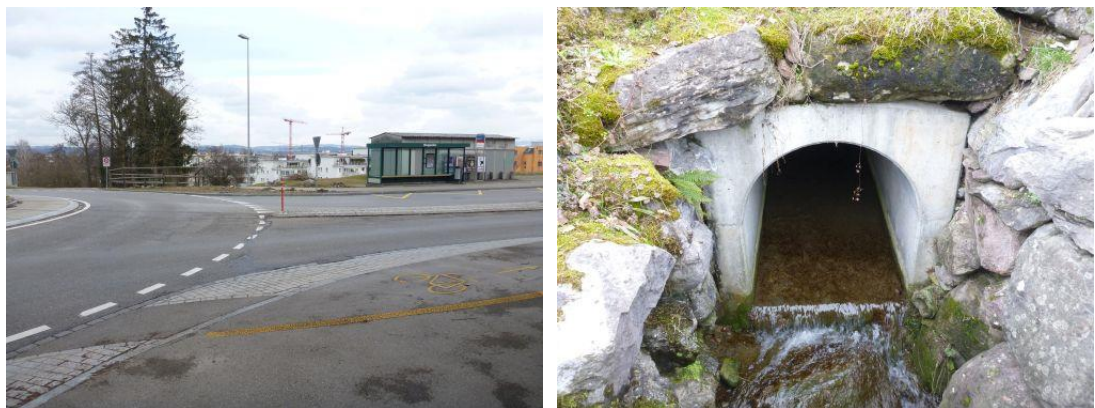
Abbildung 25: Durchlass Dübendorferstrasse – Überdeckung (links), Durchlass (rechts, gegen Fließrichtung)
