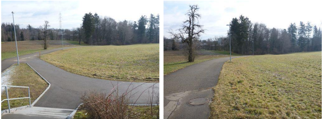
Abbildung 40: Eindolung Langwisbach, Blick in Fließrichtung
