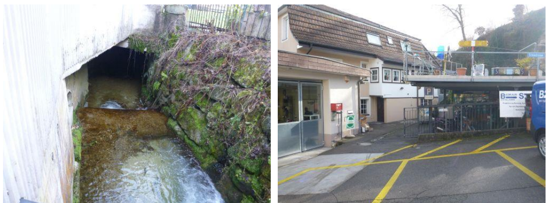
Abbildung 32: Eindolung Dorfbach – Einlauf (links), Überstellung durch Gebäude (rechts)
