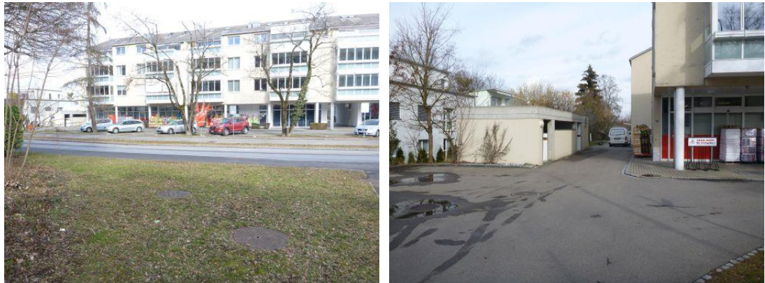
Abbildung 41: Eindolung Fröschbach – Langäri (oben links, gegen Fliessrichtung), Breiteli (oben rechts), Maurstrasse (unten links) und unterhalb Maurstrasse (unten rechts)
