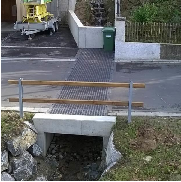
Beispiel Strassenquerung mit Gussrost: Spitalerbach, Zürich.
