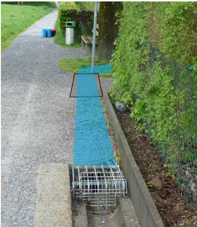
Weiterführung der Oberflächenentwässerung, mit Gussrostübergang bei der Querung des Armenbachwegs.
