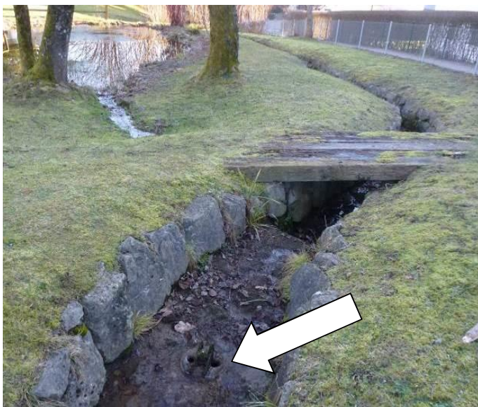
Wasserfassung in der Bachsohle (Pfeil) und Weiher im Nebenschluss auf dem Areal des Alterszentrums. Steg zur Bewirtschaftung des rechten Uferstreifens.
