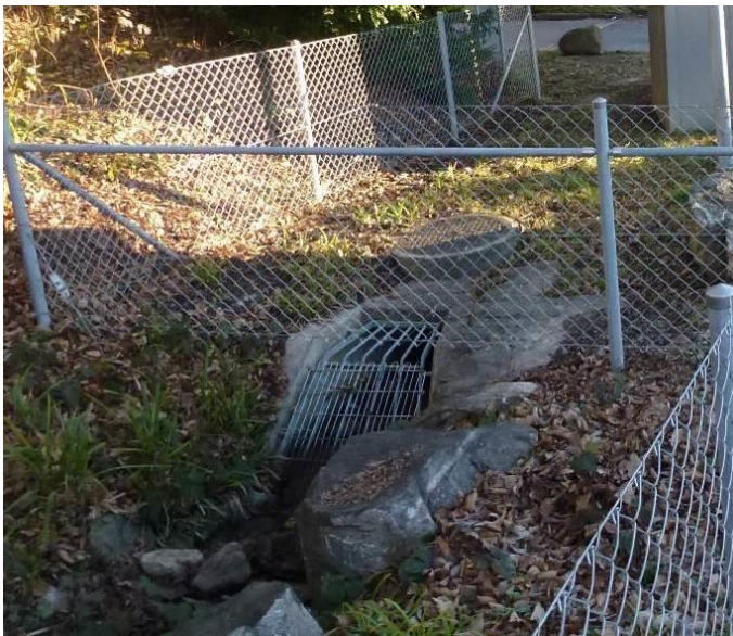
Einlaufbauwerk mit Geschwemmsel-rechen
