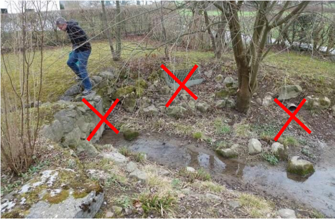
Wehr, Ausleitbauwerk, Kanäle, Schächte usw. sollen abgebrochen werden.
