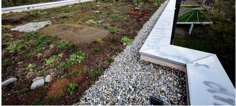
Abbildung 3: Dach mit verschiedenen biodiversitätsfördernden Strukturen (Quelle: www.nnbs.ch )
