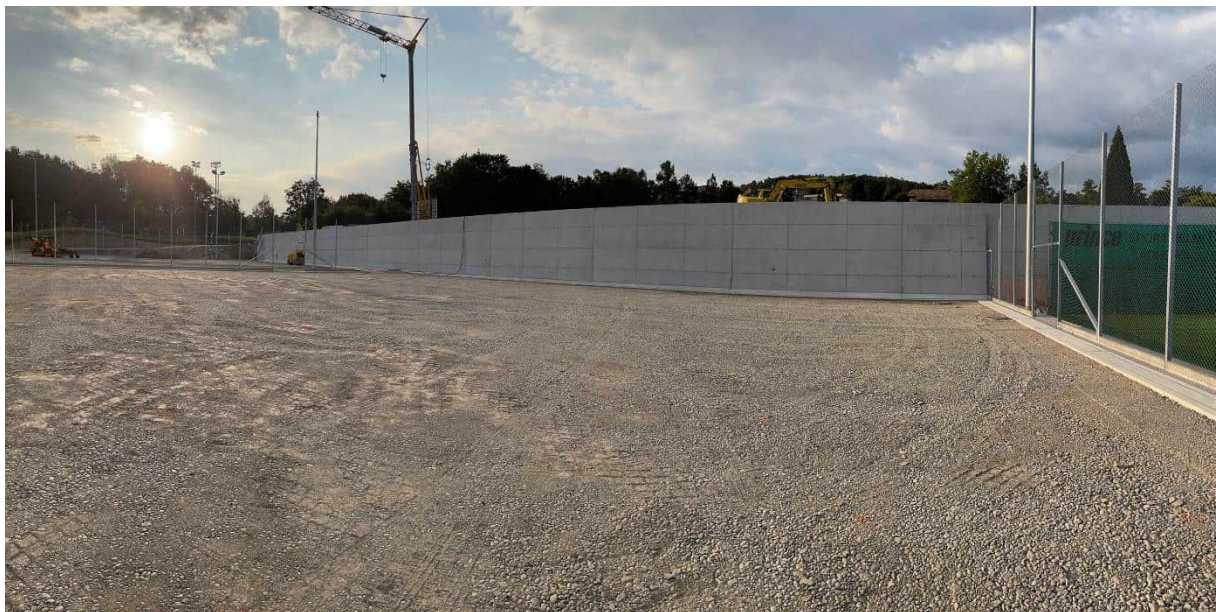
Abbildung 9: Stützmauer zwischen Tennisfeldern und geplantem Neubau (Sicht von den Tennisfeldern her)
