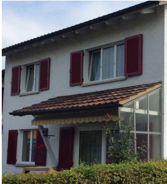
Abbildung 38: Bestehendes Beispiel für Klappläden inkl. Sonnenstoren
