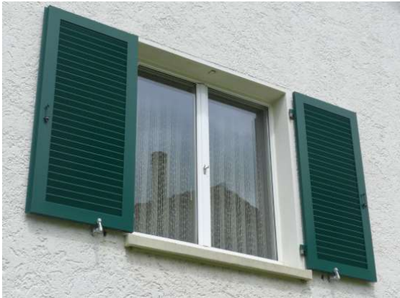
Abbildung 34: Ursprüngliche Leibungstiefe und schmaler Mittelpartie am Fenster
