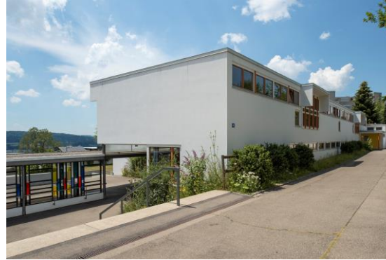
Abbildung 6: Ansicht von Osten auf Pausenhalle & Trakt West
