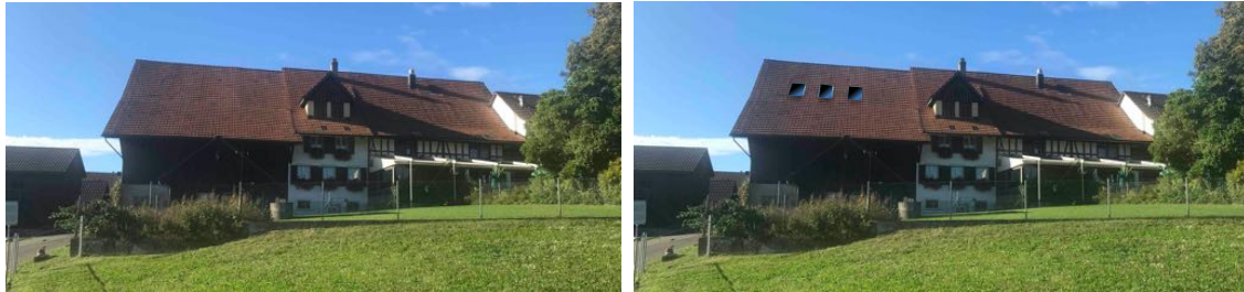
Vers.-Nr. 119, schutzwürdige Baute gemäss Detailplan, mit drei neuen Dachflächenfenster (Dachfläche ca. 130 m 2 )
