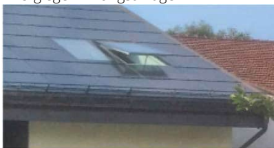
Integrierte Dachflächenfenster bei Energiegewinnungsanlagen
