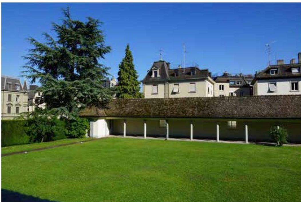
Abb. 6 Laubengang, aufgenommen von der Gartenanlage aus
