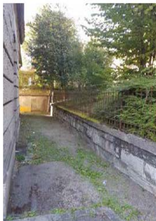
Abb. 9 Stützmauer als neuer Grenzverlauf
