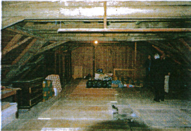
Dachgeschoss Wohnteil, Blick nach Westen
