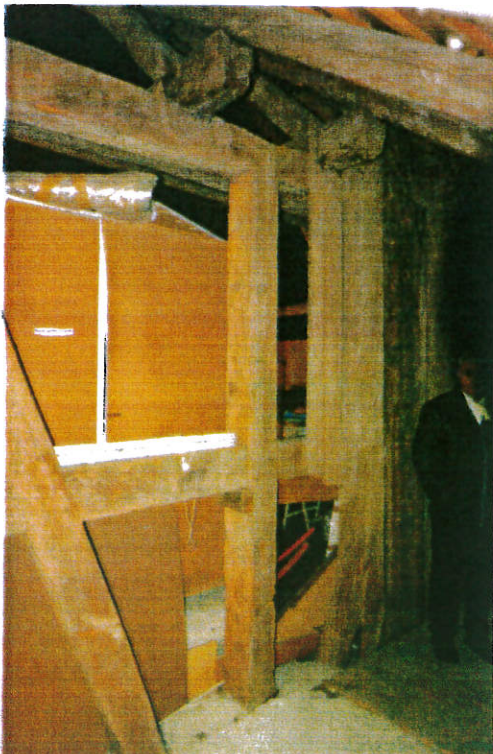
Riegel der ehemalige Nordfassade, Blick von aussen unter abgeschlepptem Dach.
