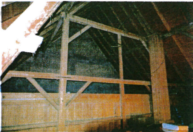
Dachstuhl Scheune. Blick nach Westen mit ehemaliger Giebelwand West. Dahinter die Erweiterung mit gemauerter Giebelwand.
