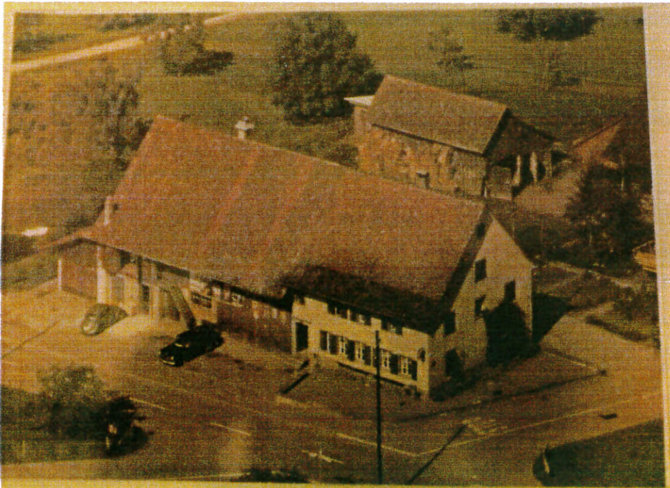
Flugaufnahme, vor dem Umbau 1973, noch mit verputzter Fassade und ohne Parkplätze. (Familienbesitz Berger)
