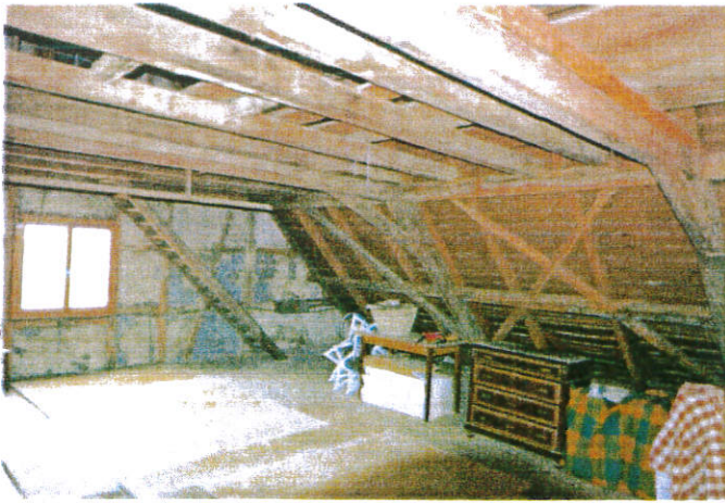
Dachgeschoss Wohnteil, Blick nach Osten.
