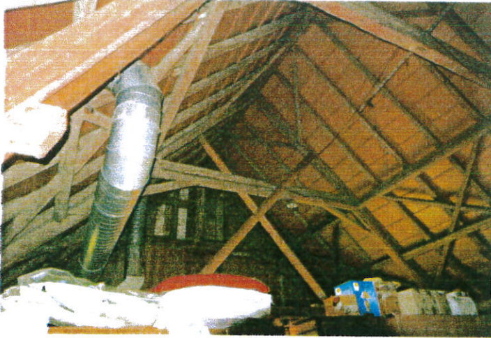
Dachgeschoss Scheune, Blick nach Osten, Sekundäre Verstreibungen sichern das Dachgerüst. Links abgesägter Ankerbalken.
