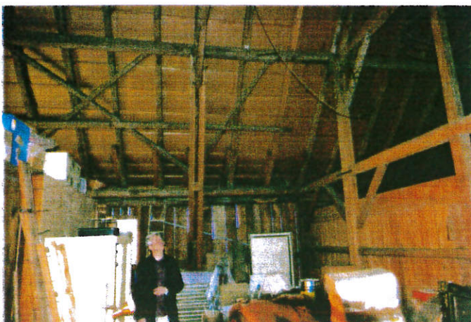
Heuboden mit Blick nach Süden.
