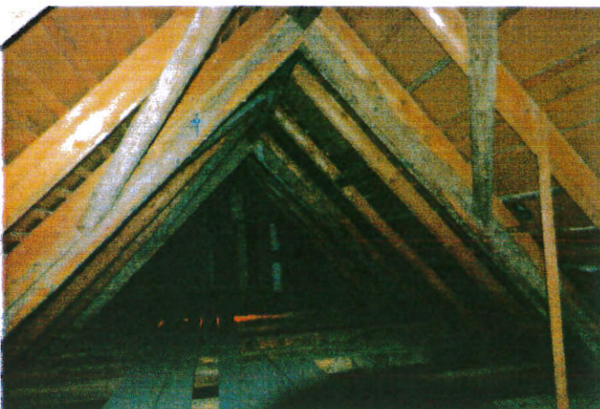
Dachgeschoss Wohnteil. Kehlboden.
