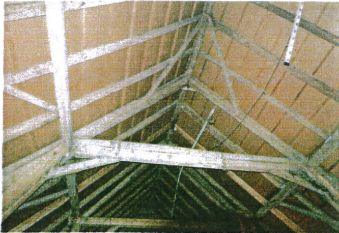
Dachkonstruktion Scheune mit liegendem Dachstuhl.
