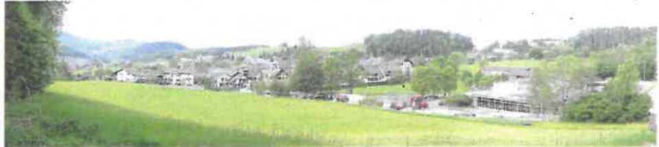
Abb. 25: Schulhaus Schweikrüti (Quelle: PLANAR, 2017)
