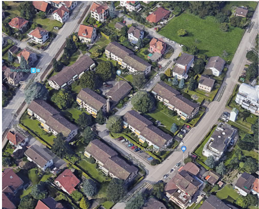
Abbildung 2: Bestehende Wohnsiedlung in Dietikon (Quelle: Google)
