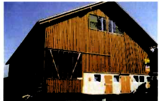
Abb. 6 und 7: Beispiele gefälliger Fassadengestaltung von landw. Gebäuden
