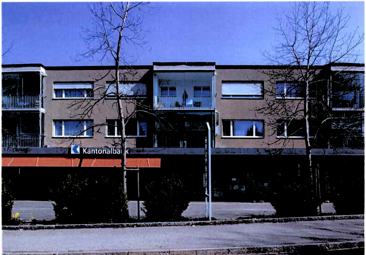
Ansicht von Südenwesten
