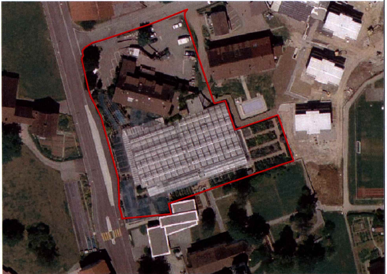
Abbildung Nr. 1: Flugaufnahme mit Perimeter, Bildquelle: www.gis.zh.ch (März 2011)
