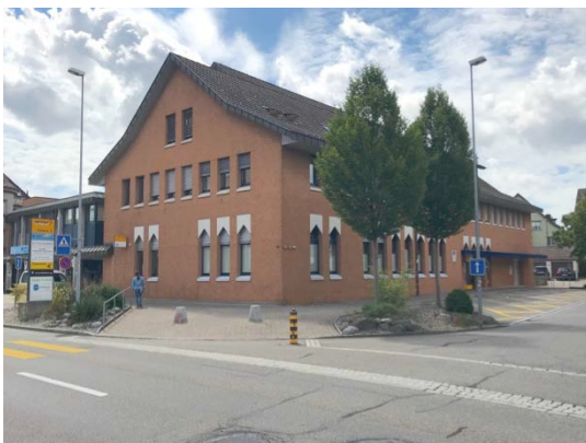
Bahnhofstrasse 14 (u.a. Post) über die Kreuzung Bahnhofstrasse/Gerichtshausstrasse gesehen (Stockwerkeigentümergeinschaft)
