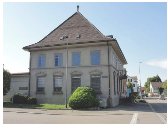
Bahnhofstrasse 16 (Bankgebäude) über die Bankstrasse gesehen (Schutzobjekt, Bank Avera, ehem. Clientis)
