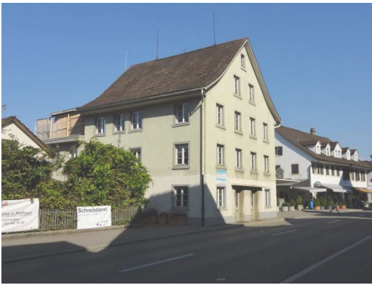
Hochstrasse 7 von gegenüberliegender Strassenseite aus gesehen (Schlössli, Schutzobjekt Gemeinde Pfäffikon ZH)
