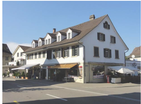
Hochstrasse 11 und 15 von gegenüberliegender Strassenseite aus gesehen (P. Hefti)
