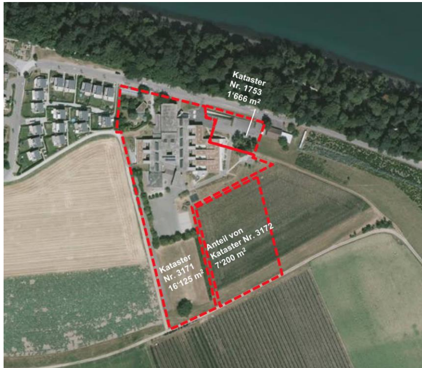
Abb. 17 Situation und Flächenbedarf zum Bau des Sekundarschulhauses mit Einfachturnhalle (Quelle: Bericht Standortvergleich, 11. Juni 2018, schul raum entwicklung, Wetzikon)
