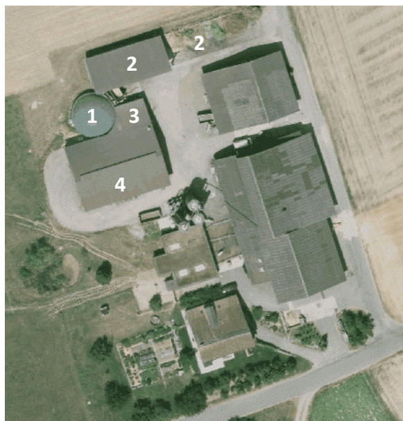
Abbildung 1: Ansicht der Sunnehofenergie GmbH mit Fermenter (1), Substratlager (2), Technikraum (3) und Kompostierhalle (4) (GIS ZH, 2016)
